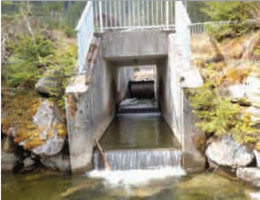
Die alte Fischaufstiegshilfe
