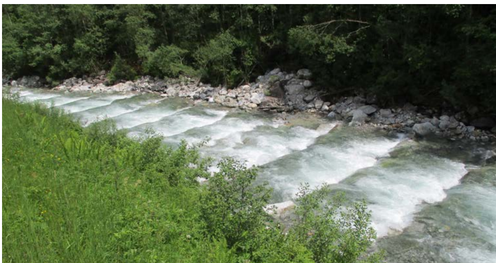
Querbauwerk 1 nach Sanie- rung
