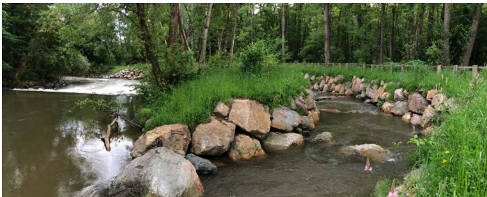
Ausstieg aus der Fischaufstiegshilfe. Blickrichtung flussabwärts
