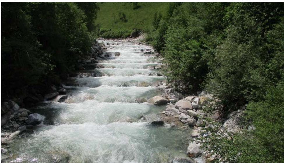
Querbauwerk Triebwasser- leitung nach Sanierung
