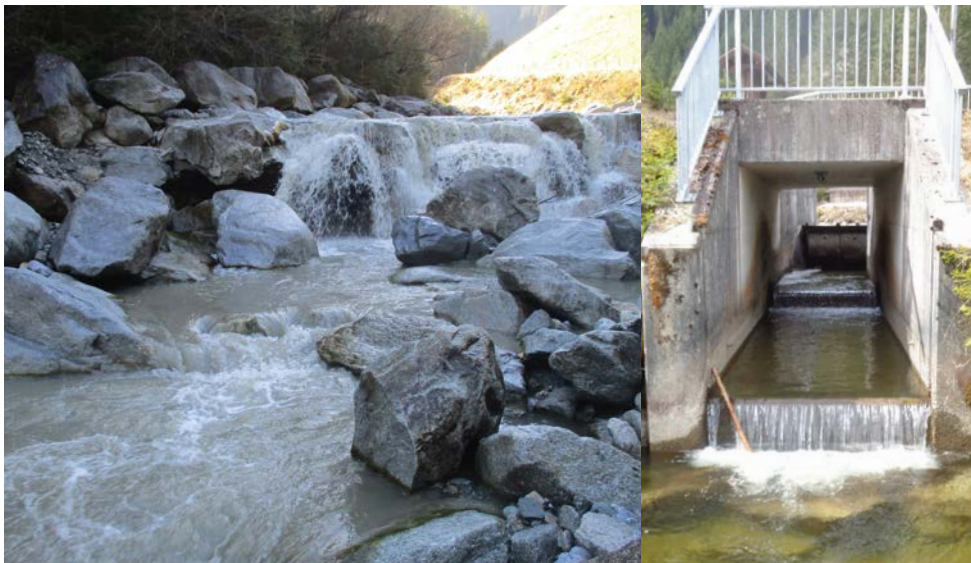
links: Querbauwerk 1 vor Sanierung
