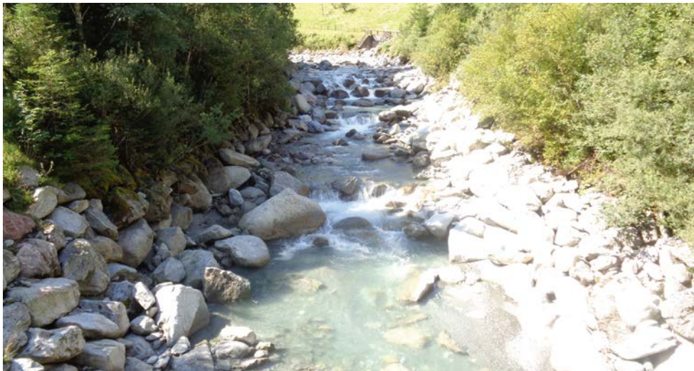
Querbauwerk Triebwasser- leitung unpassierbar
